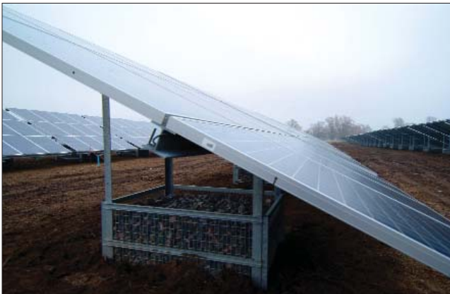
Gebrauchsmustergeschützte Gabione (Steinkorb)
