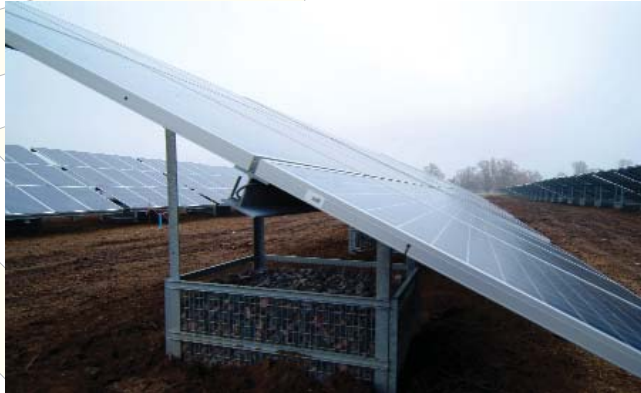
Errichtung auf patentierten Natursteinkörben (Gabionen)
